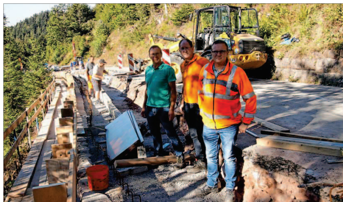
Auf der Baustelle auf dem „Sandsteig“: (v. l.) Bauaufseher Richard Wurth (Regierungspräsidium Freiburg), Bauleiter Andreas Franz (Rendler Bau Offenburg) und Projektleiter Andreas Maier (Regierungspräsidium Freiburg).
